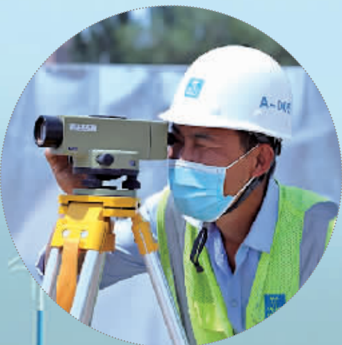
◆在呼和浩特建设项目工地,中建三局的测量人员正在开展施工现场测量改变工作。
