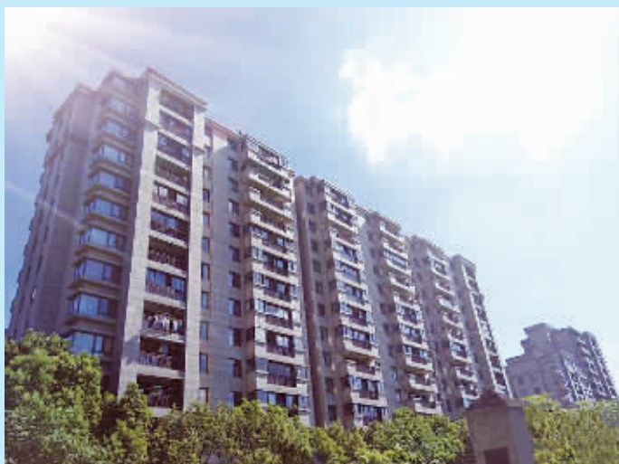
◆杭州某住宅楼。
