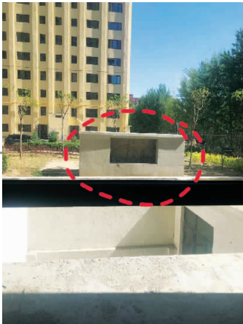
◆刘先生家楼前的地下车库排风口
