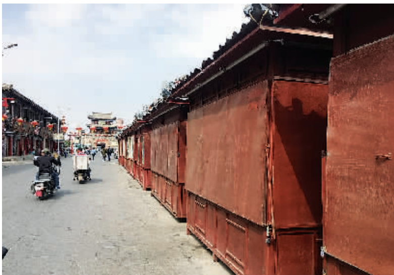
◆10间“占道经营”小屋放置5个月未拆除 晨报融媒记者 郭治华摄影
